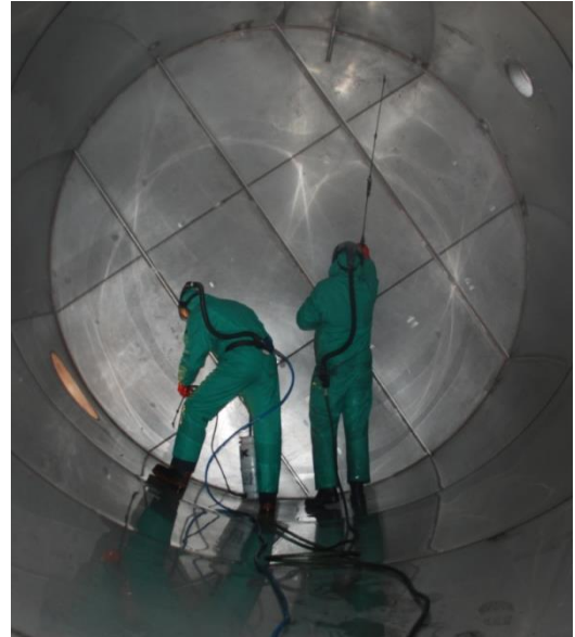
Sproei-beitsen van een RVS tank
